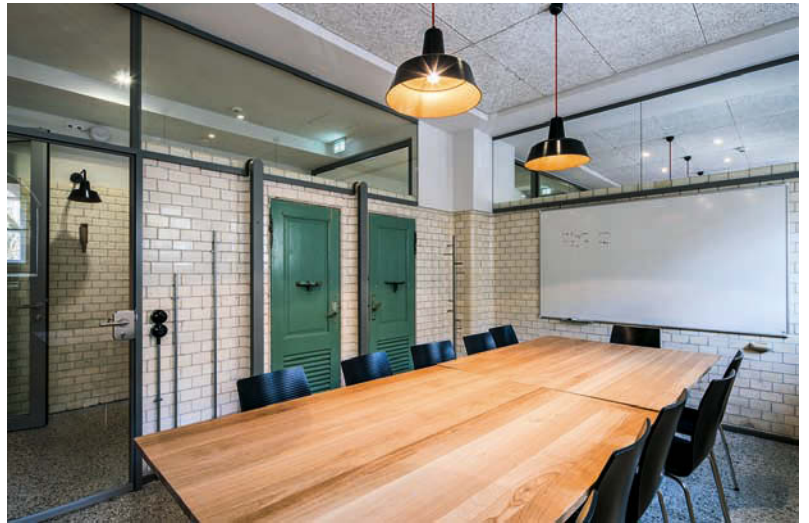
In den Seminarräumen wurden neue Glastüren eingesetzt und die ursprünglichen Holztüren mit Lüftungslamellen daneben belassen. • The original wooden doors with ventilation lamellas were maintained alongside.
