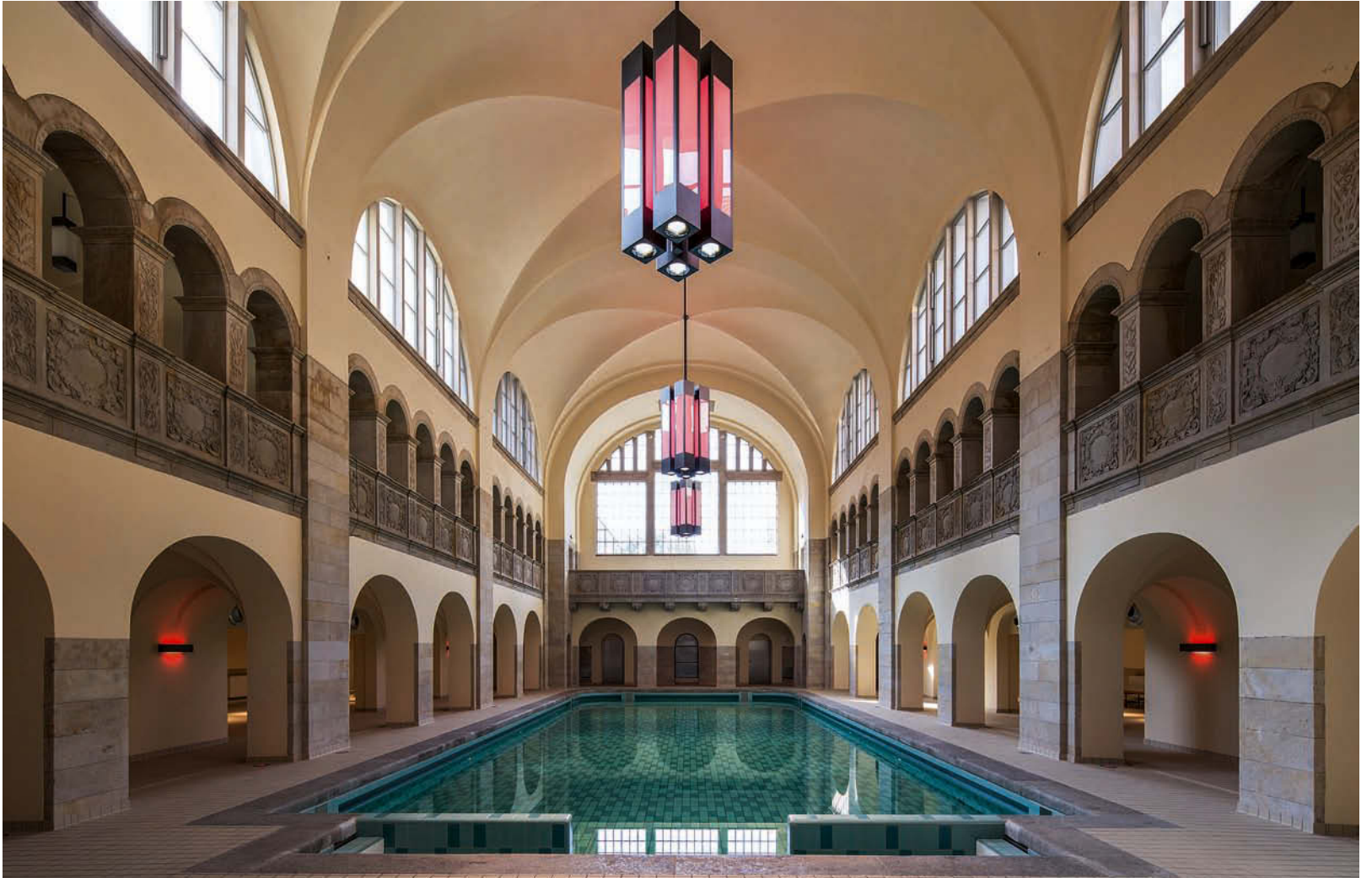
Durch die Luken im Schwimmbecken lässt sich das Wasser ablassen und der Boden kann gleichzeitig nach oben gefahren werden. • Water can be drained through the hatches in the pool and the bottom can be simultaneously raised.
